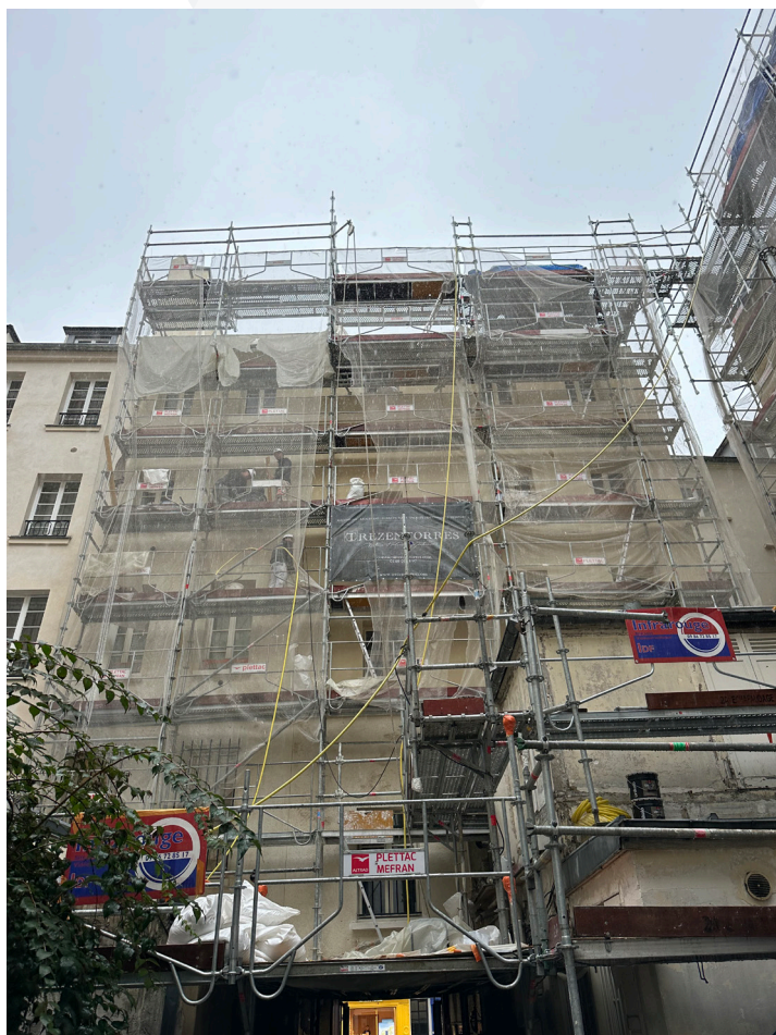
Façade intérieure en travaux.
