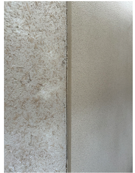
L'enduit Kalamua ® de SAINT-ASTIER ® s'applique frais dans frais - ici sur le Batichanvre BL-TS ® - (épaisseur 20 mm).
