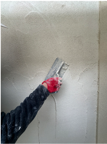
Application manuelle de l'enduit Kalamua ®.
